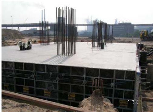
Bild 3 Kabelschutzrohre im Fundament nach dem Betonieren
