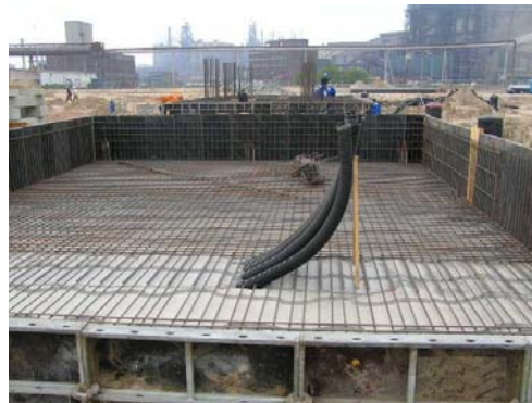
Bild 2 Kabelschutzrohre im Fundament
