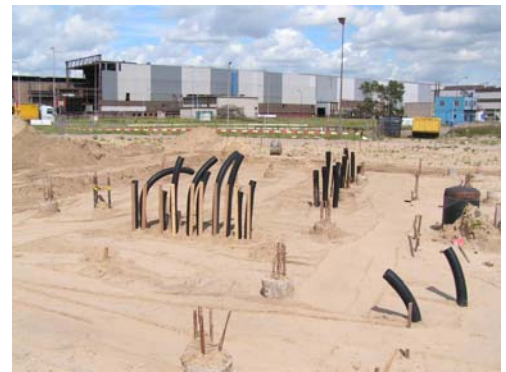
Bild 1 Kabelschutzrohre im Fundament
