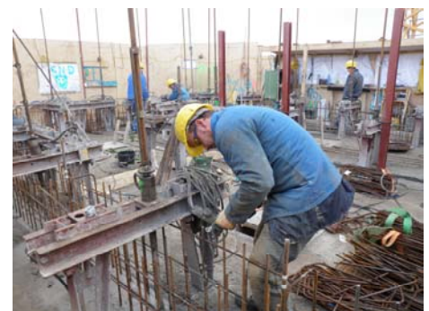
Bild 4 Arbeiten auf der Plattform. Hydraulikvorrichtung mit Hängebock
