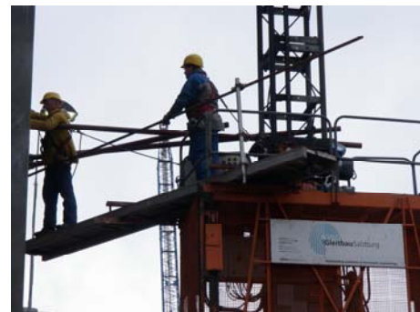
Bild 12 Abbau des Bauaufzugs
