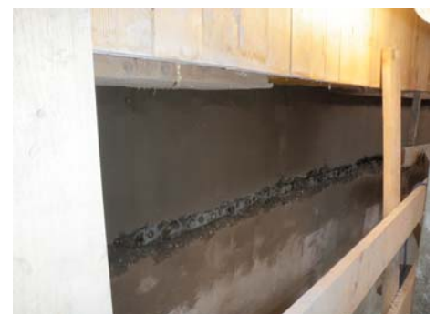
Bild 8 Bewehrungsanschluss mit Gewinde
