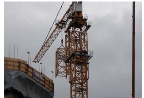
Bild 2 Turmdrehkran wächst durch Einbau von Turmgliedern.
