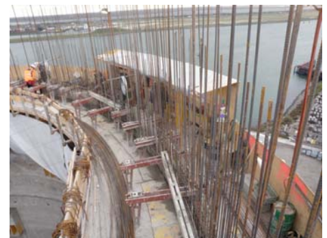
Bild 6 Arbeitsplattform eines Silos
