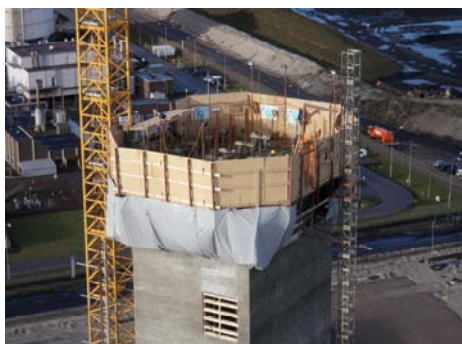
Bild 11 Blick in eine Arbeitsplattform
