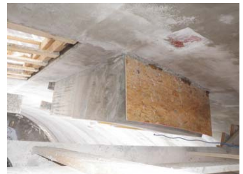
Bild 3 Konsole direkt fugenlos betoniert
