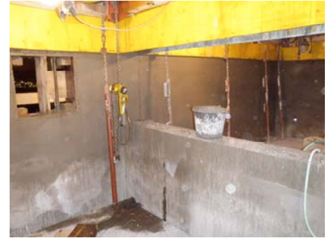
Bild 5 In der tiefer gelegenen Arbeitsplattform unterhalb der Gleitschalung.
