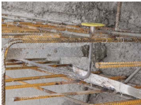
Bild 10 Angeschweißte Erdungsplatte
