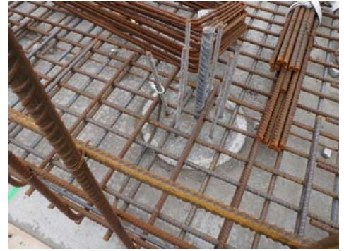
Bild 1 Anschluss Erdungsrundstahl Ø 10mm an Pfahl
