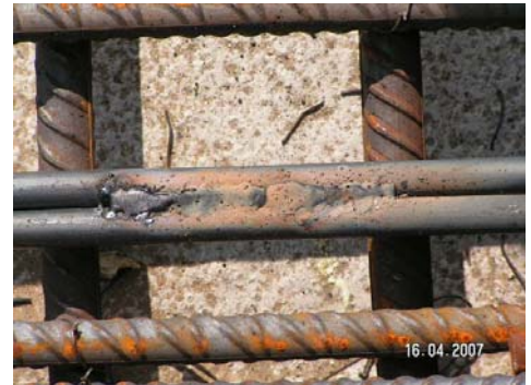
Bild 2 Schweißanschluss Erdungsrundstahl Ø 10mm
