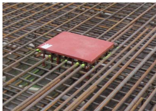
Bild 3.2 Ankerplatte auf Oberseite einer Bodenplatte
