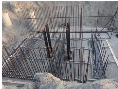
Bild 2.3 Unterkonstruktion zur Aufnahme der Ankerbox
