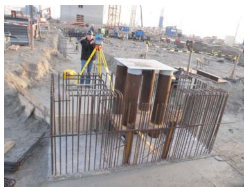
Bild 2.4 Fixierte Ankerboxen an Unterkonstruktion. Vermesser bei der Kontrollmessung.
