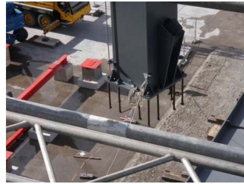
Bild. 2.5 Montage Stahlstütze mit Hammerkopf Anker
