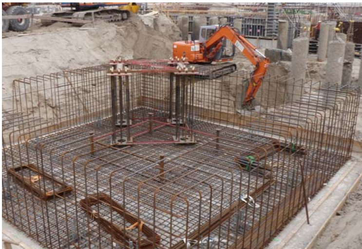
Bild. 1.3 Unterkonstruktion zur Aufnahme von Gewindeanker.
