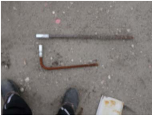
Bild 4.1 Bewehrungsschraubanschluss gerade und gebogen
